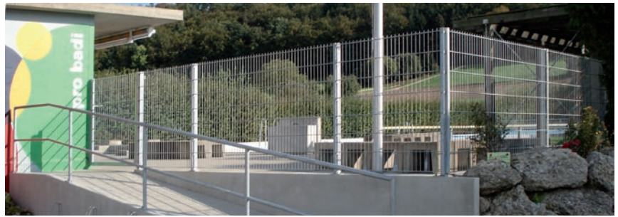
Doppelstabmattenzaun und Metallgeländer
